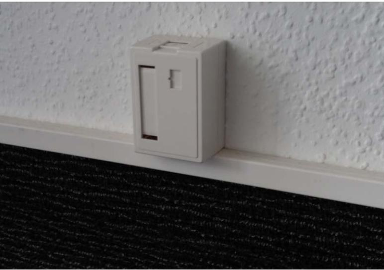
Kleine Aufputz-Modulaufnahmen mit kurzen RJ45-Modulen benötigen nur wenig Platz und fallen kaum auf. Der Kabelabgang nach oben längs der Wand vermeidet Stolperfallen.
